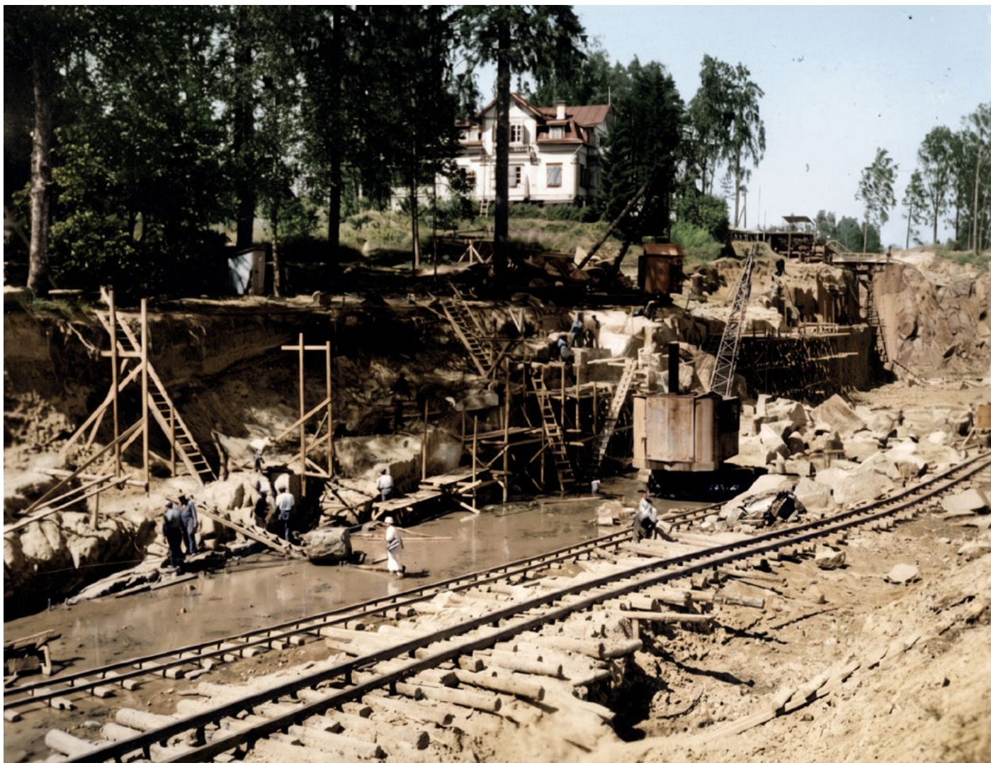
Строительная площадка. Фото колорировано.
