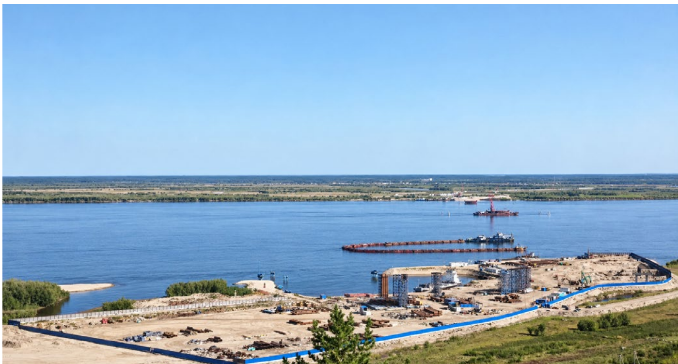
Дноуглубление в створе строительства Ленского моста.
