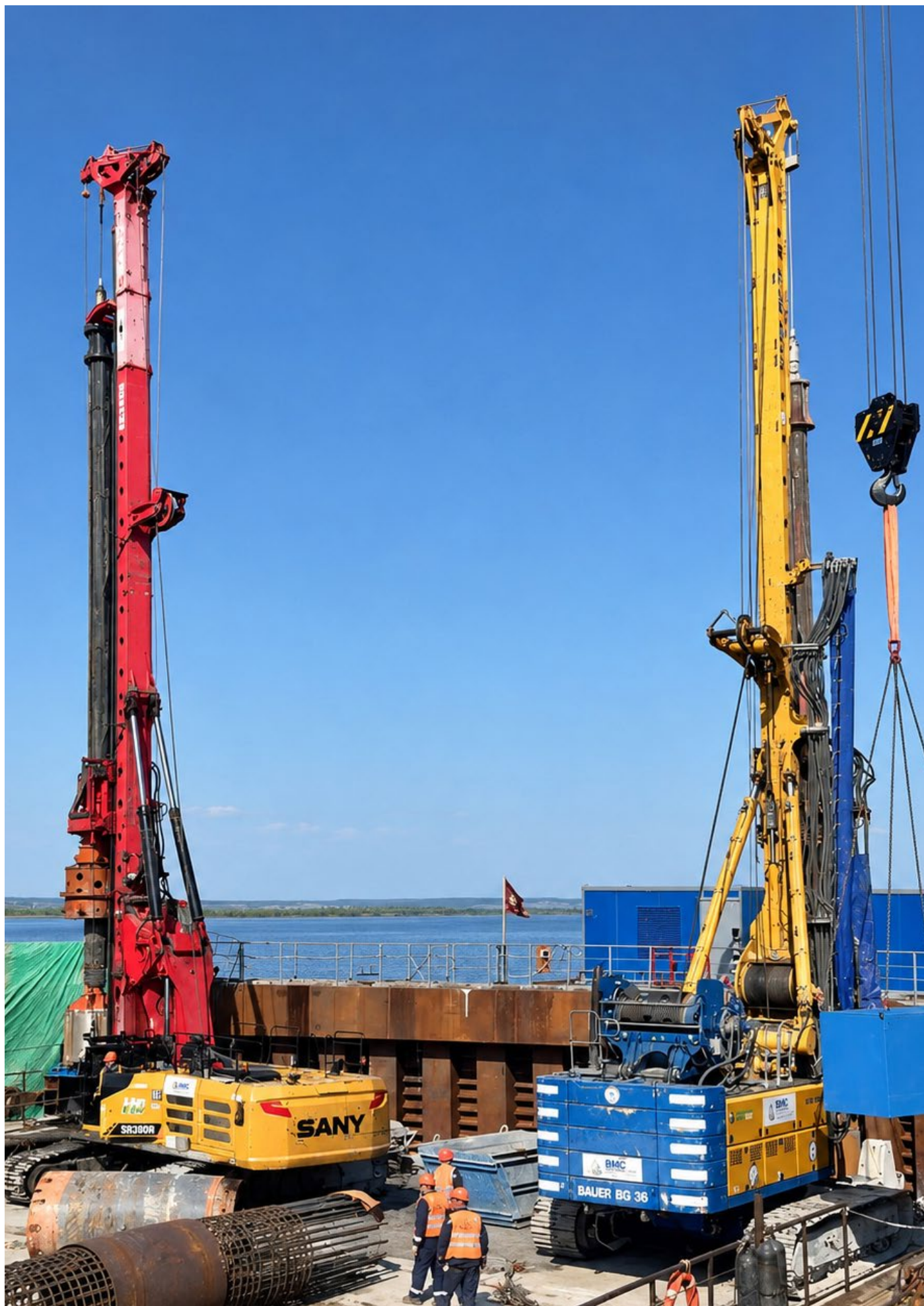
Устройство буронабивных свай для пилонов моста.
