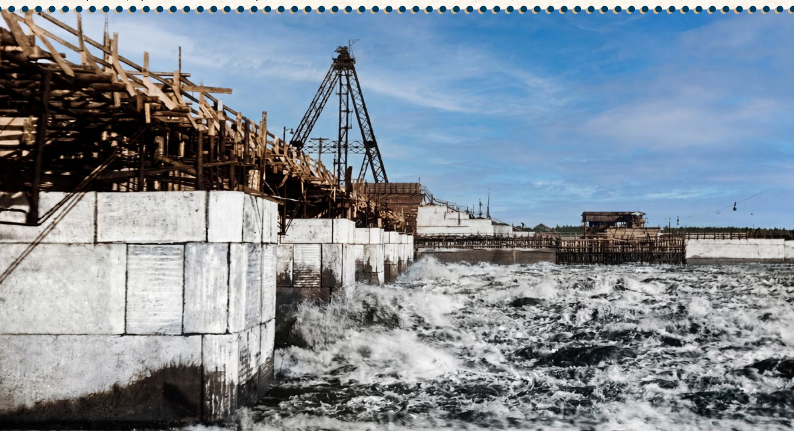
Работа водосливной плотины Угличской ГЭС. Фото колорировано.
